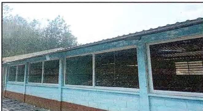
Foto 3: FASE TERMINADA COLOCACIÓN DE VENTANAS PVC
