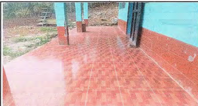
Foto 1: FINALIZACIÓN DE LA COLOCACIÓN DE CERAMICA EN EL CORREDOR
