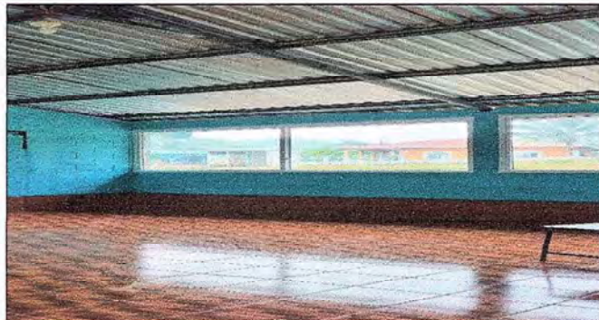
Foto 2: AULA YA TERMINADA CON LA COLOCACIÓN DE CERAMICA
